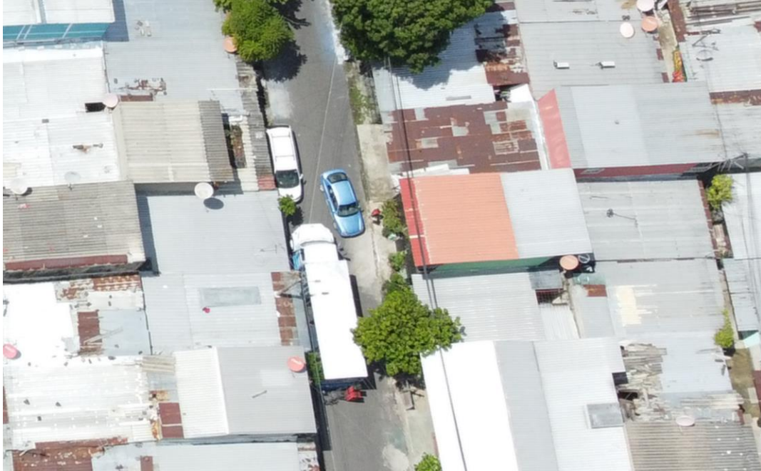
Ilustración 46. Calle en la comunidad, estrecha y sin aceras. Fuente: Propia.
