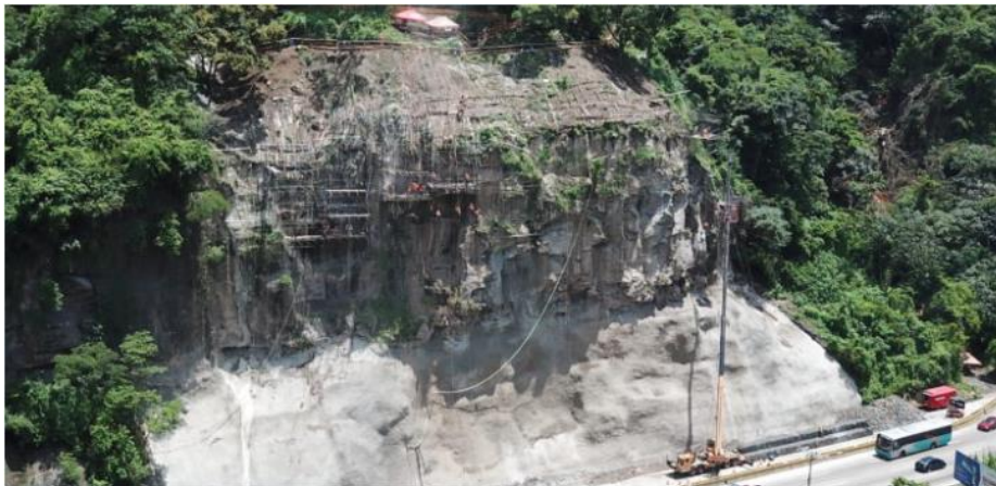
Ilustración 17: Estabilización de talud carretera a Los Chorros, Fuente: www.rodiosbo.com
