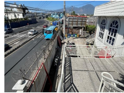
Muro divisorio del espacio público en ITEXAL dificulta acceso a pasarela. Fuente: Propia.
