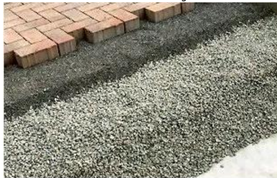
Ilustración 11: Detalle de pavimentos permeable. Fuente: sudsostenible.co
