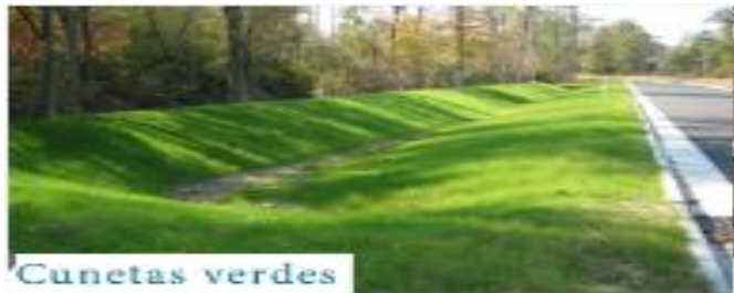
Ilustración 13: Cunetas Verdes. Fuente: www.hidrologiasostenible.com
