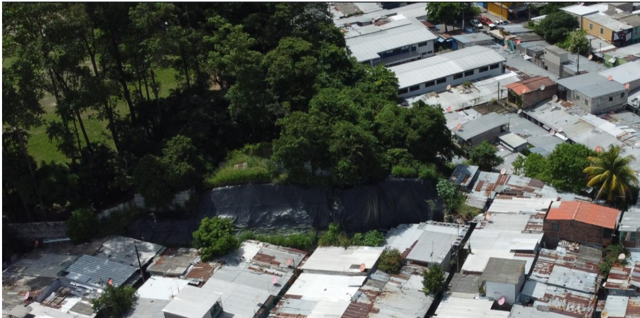
Ilustración 8. Taludes entre FENSADESAL y las Iberias. Fuente: Propia.
