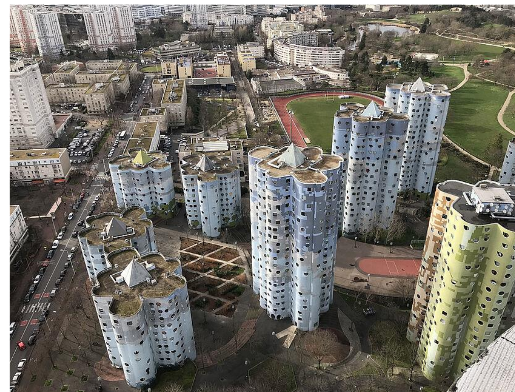
Torres de vivienda social Auilaud en Nanterre-Paris. Fuente: Nanterre.fr
