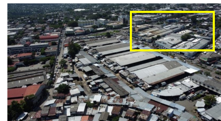
Las dos manzanas señaladas mantendrán las alineaciones de calle pero se podrá generar un espacio acerado en su interior para garantizar un mejor nivel de servicio peatonal. Fuente: Propia
